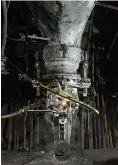
Рис. 5. Приклад встановлення сопел нової конструкції (див. рис. 4) на повітряній фурмі № 15 та повітряній фурмі № 4 ДП № 1М
