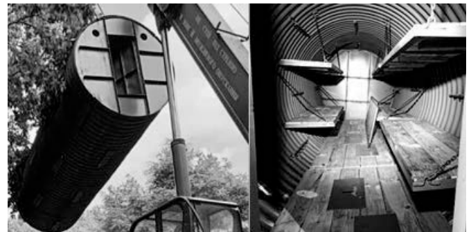
Рис. 1. Металева капсула при встановленні краном та її внутрішній інтер'єр
